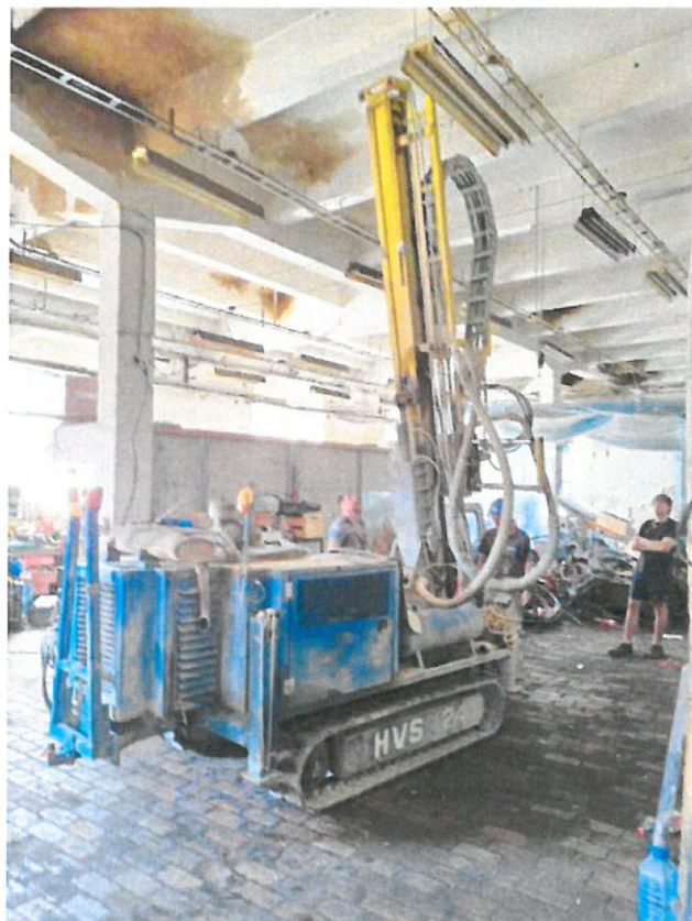
Vrtné práce v interiéru haly bývalé automatárny
